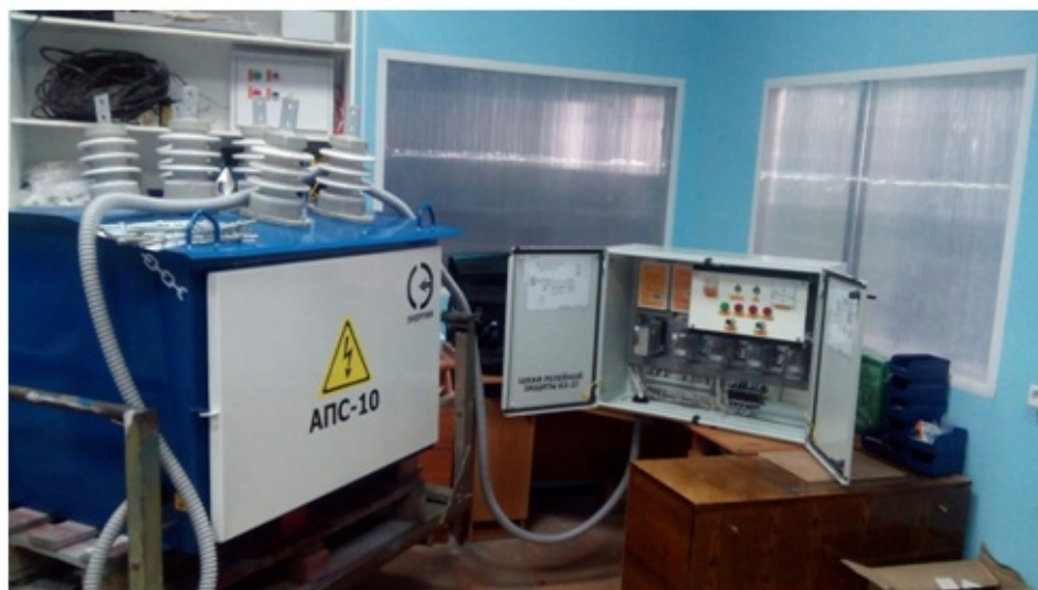
Рисунок 4 – Пункт секционирования ПС-12,5/630-УХЛ1.
