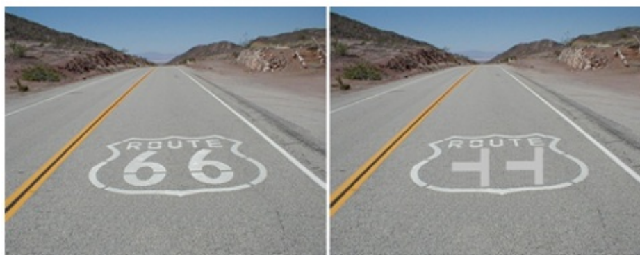
Рис.5 Номер дороги указан цифрами арабского происхождения и цифрами с наилучшим различением их
